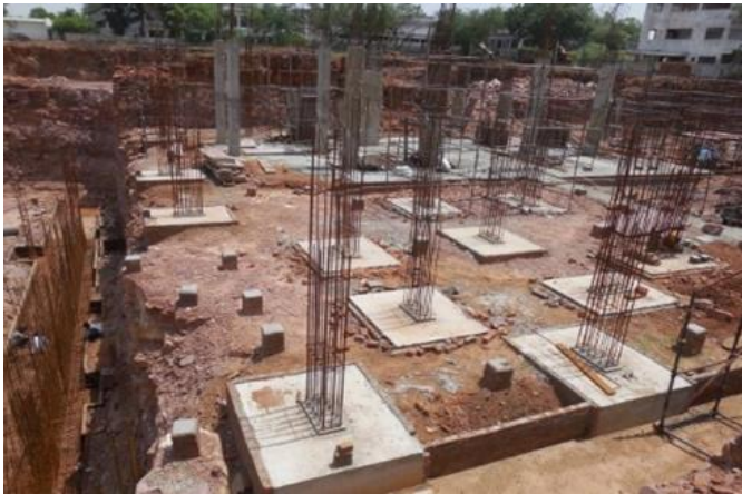
Fig. 3 Footing of actual site
